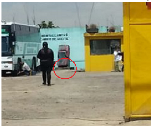
Foto 2: Vista de la ubicación del pozo identificado con el código pz-11-0212
