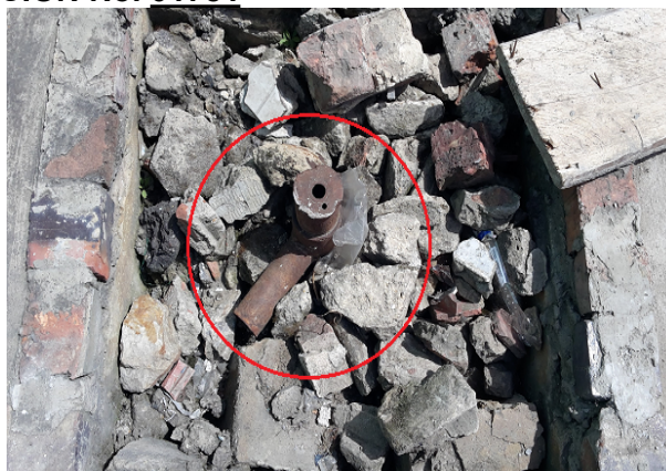
Foto 3: Vista de la boca del pozo identificado con el código pz-11-0212
